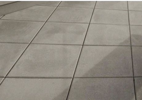
A MORTAR-SET PRECAST PAVERS
