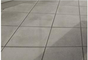
A MORTAR-SET PRECAST PAVERS
