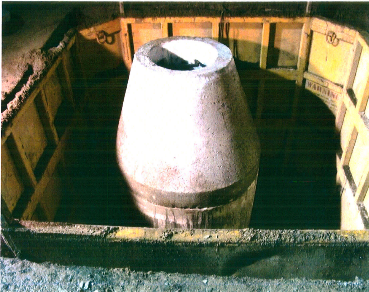
New Manhole at SE 66 th Ave.
