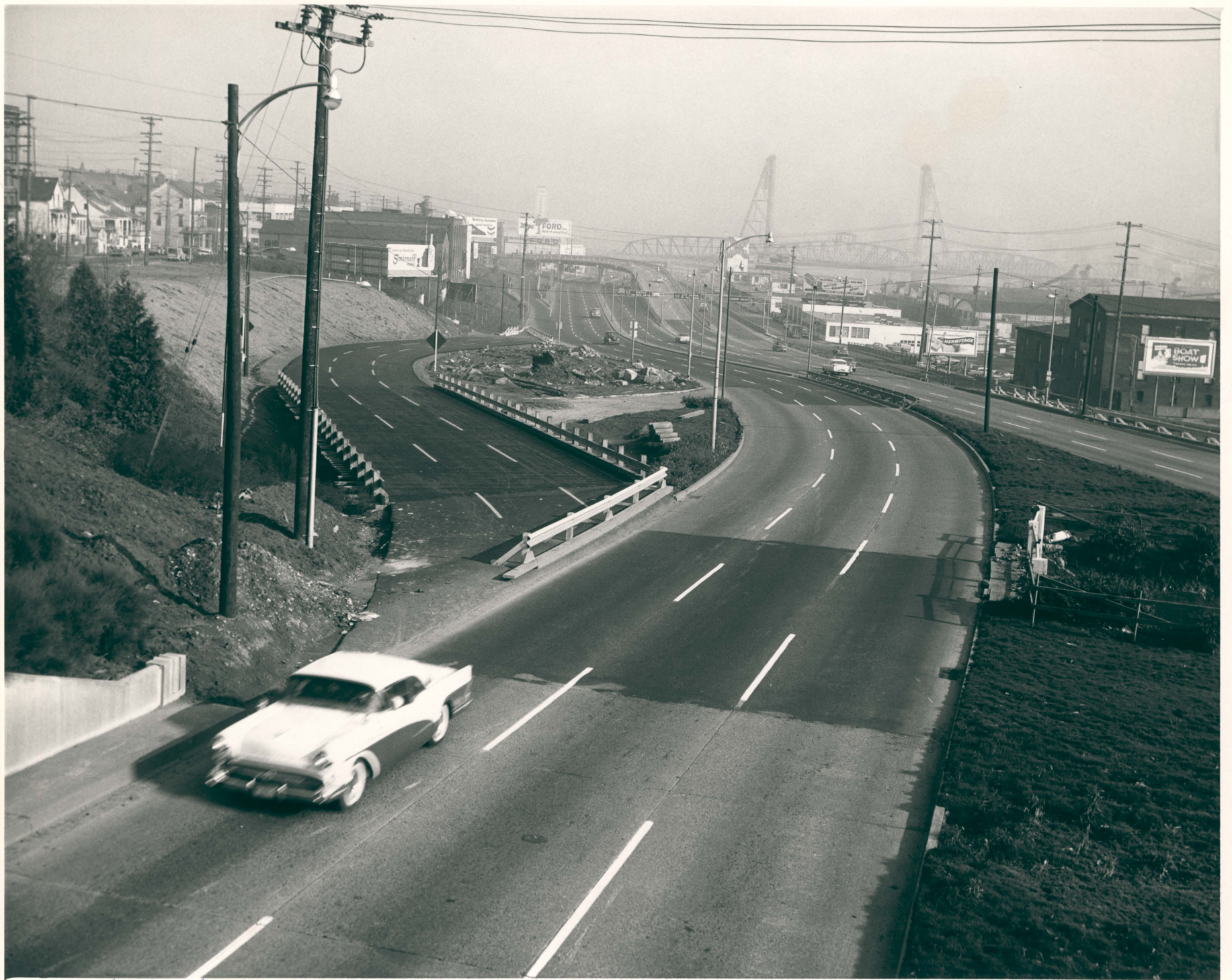
S. W. Harbor Dr. - S.B. Detour - struct. S. of Montg.
