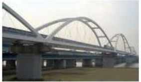
Torikai Ohas Bridge, Japan
