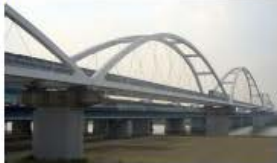
Torikai Ohas Bridge, Japan
