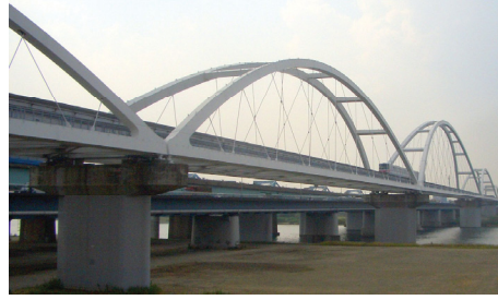
Torikai Ohas Bridge, Japan
