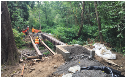
Foley-Balmer bridge construction
