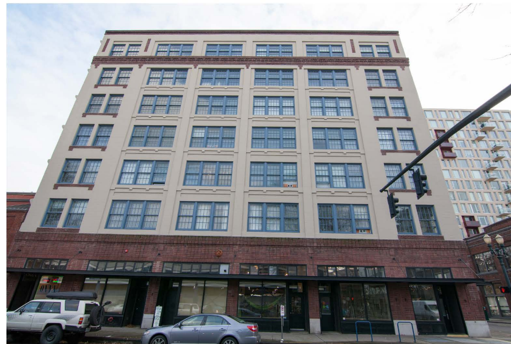
E. Honeyman Lofts
